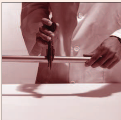
Fig. 21 Taglio dei tubi Pipe cutting
