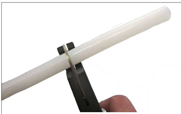
Pexrøret afkortes vinkelret med en pex saks.
